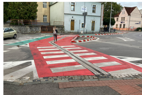
Problematické vodorovné dopravní značení
